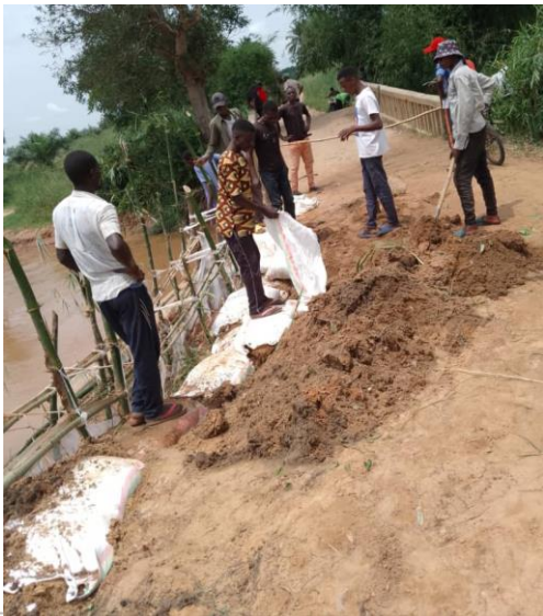
de brug wordt versterkt/le pont est renforcé
