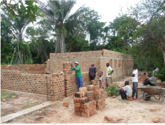
de bouw gaat verder/ la construction continue
