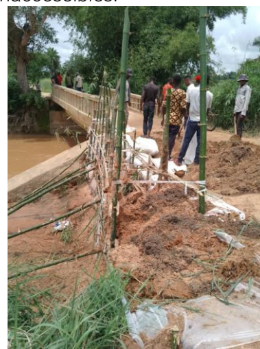
le pont est renforcé/de brug wordt versterkt
